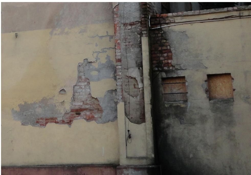
Fot.12. Ubytki i zawilgocenia tynku
