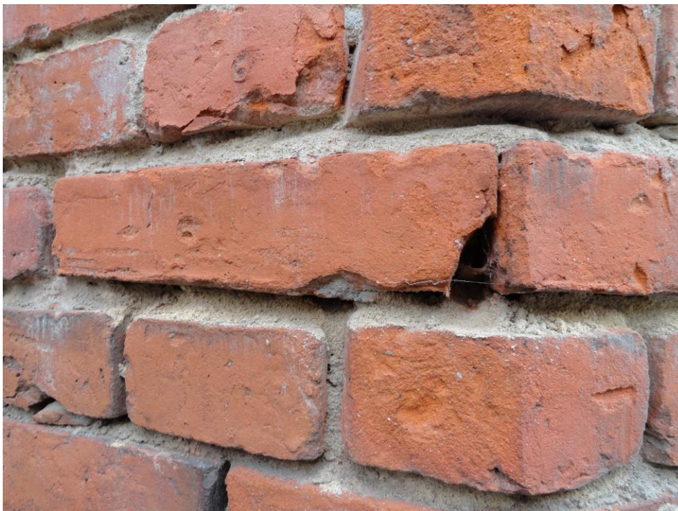
Fot.11. Ubytki w spoinach
