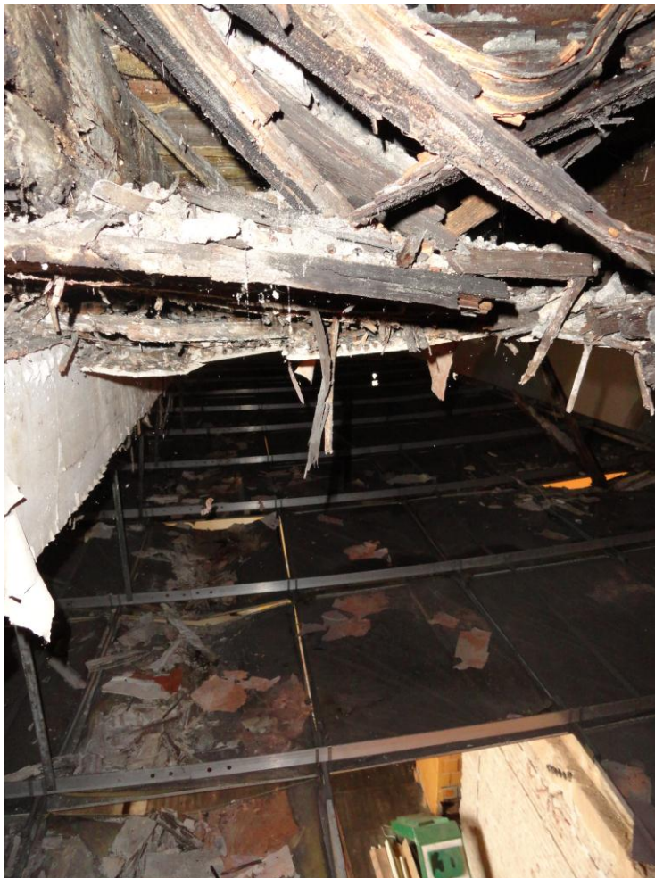
Fot.18. Uszkodzona konstrukcja stropu
