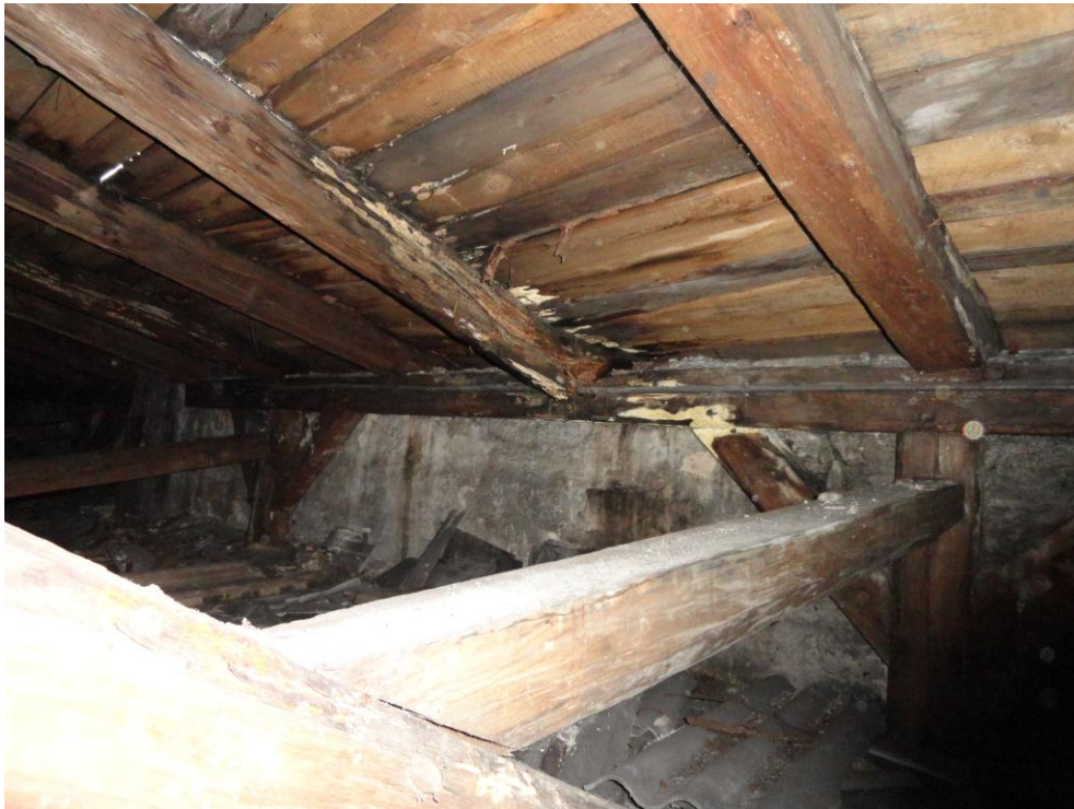
Fot.19. Elementy więźby dachowej zniszczone przez brak szczelności pokrycia dachowego
