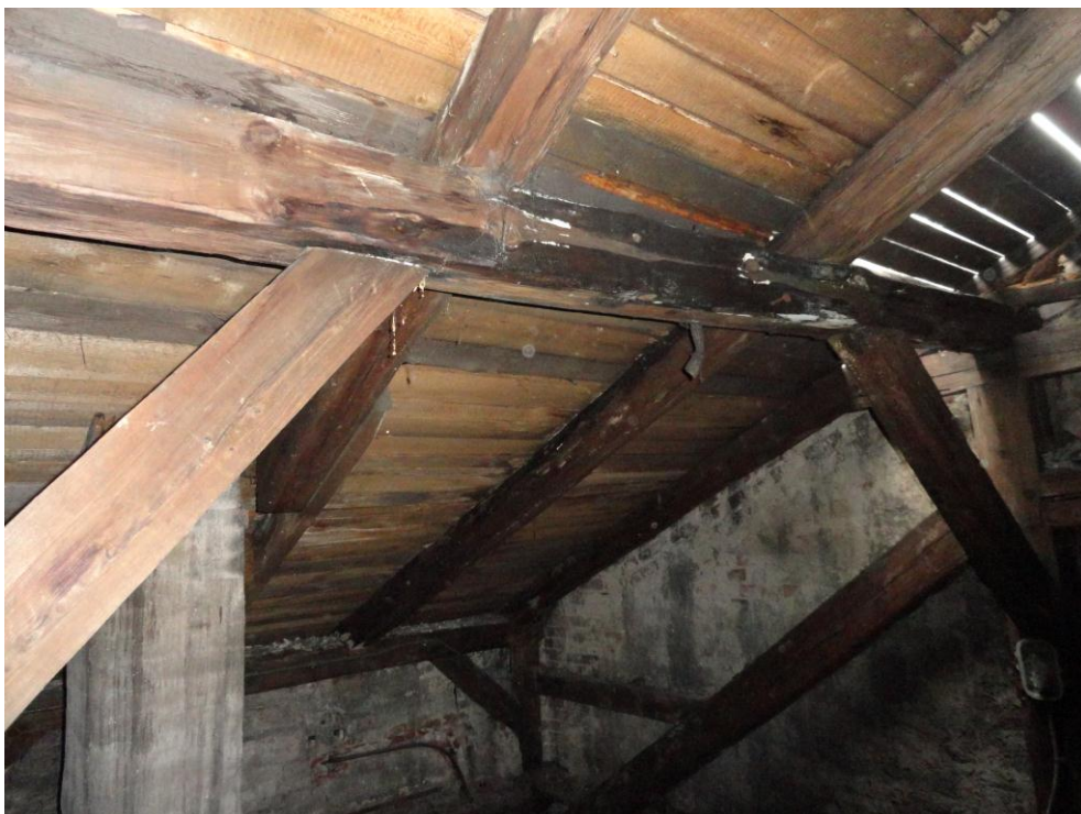
Fot.20. Elementy więźby dachowej zniszczone przez brak szczelności pokrycia dachowego
