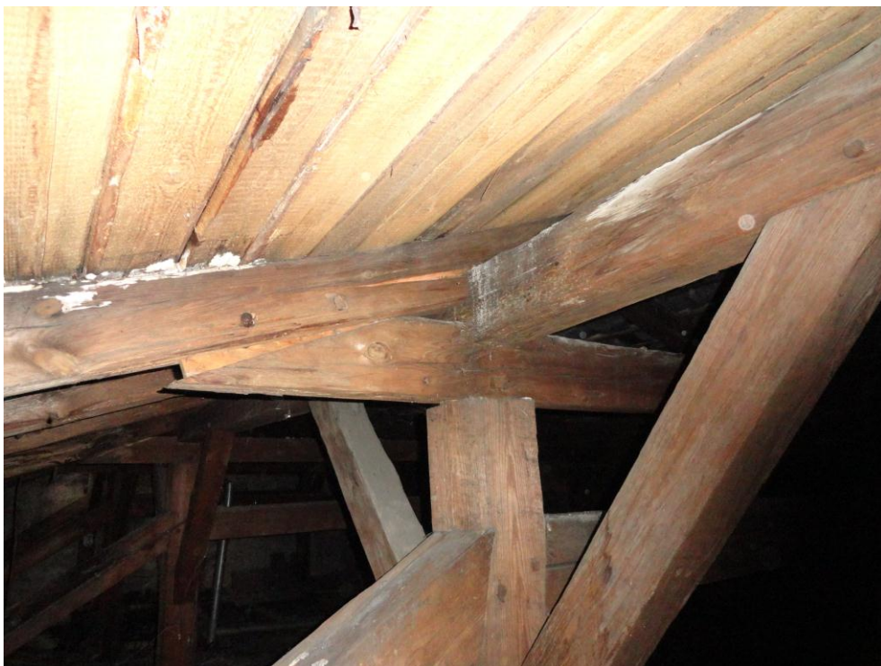
Fot.21. Uszkodzony węzeł dźwigara dachowego
