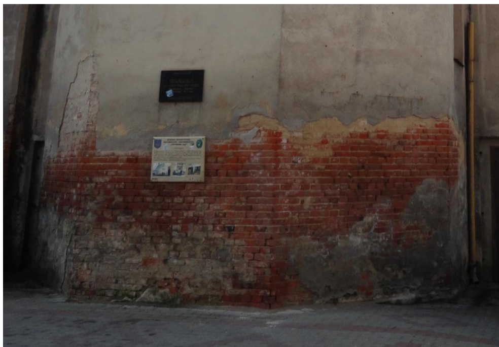
Fot.13. Ubytki i zawilgocenie tynku na absydzie
