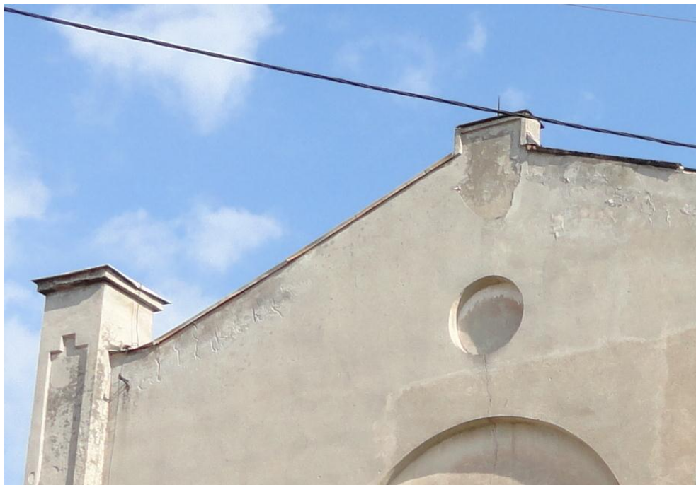
Fot.7. Zarysowanie ściany szczytowej
