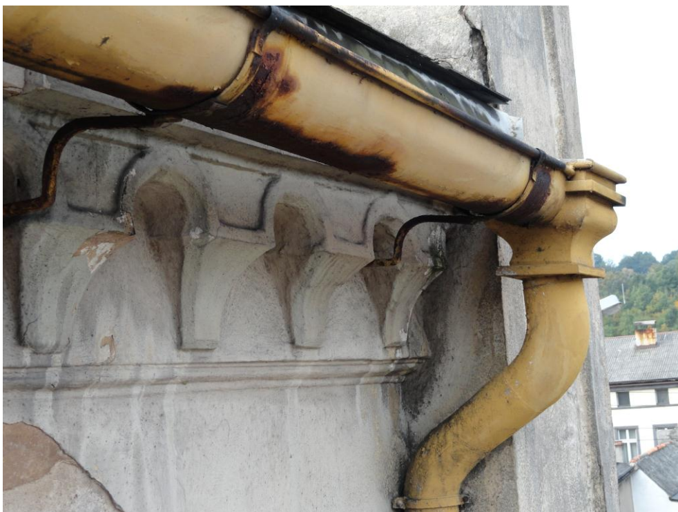
Fot.6. Widok rynny z koszem spustowym
