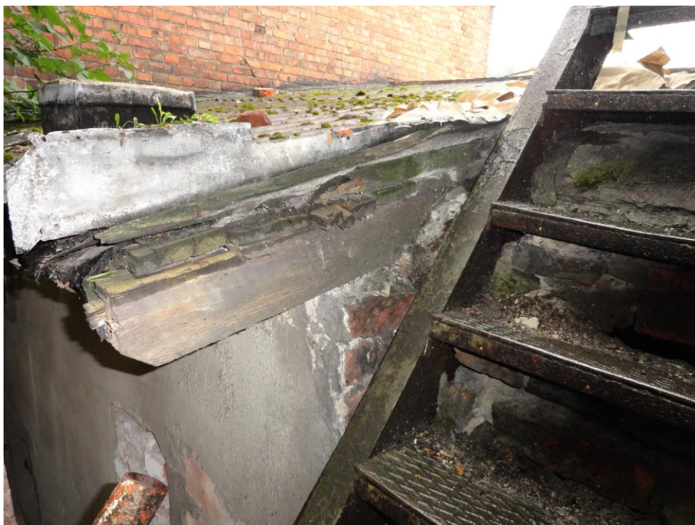
Fot.3. Postępująca degradacja murów i konstrukcji dachu
