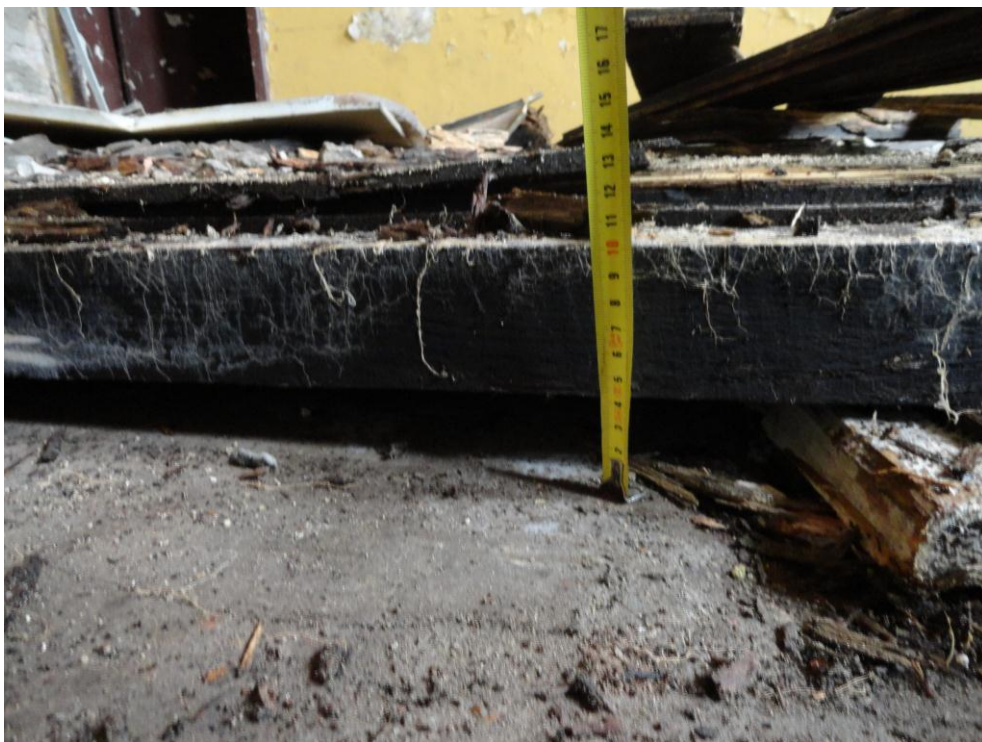
Fot.16. Przekrój przez podłogę w sali głównej
