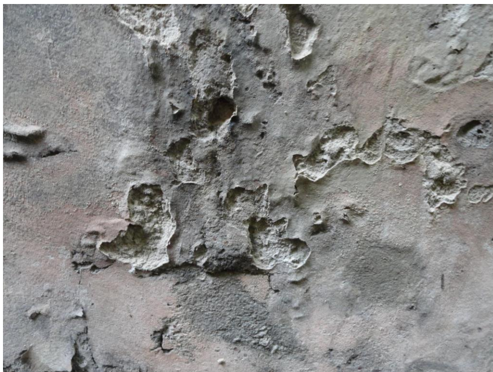
Fot.10. Wykwity solne na tynku zewnętrznym
