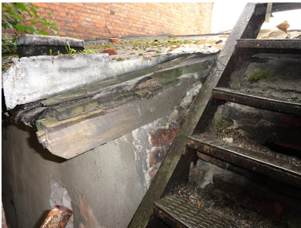
Fot.3. Postępująca degradacja murów i konstrukcji dachu
