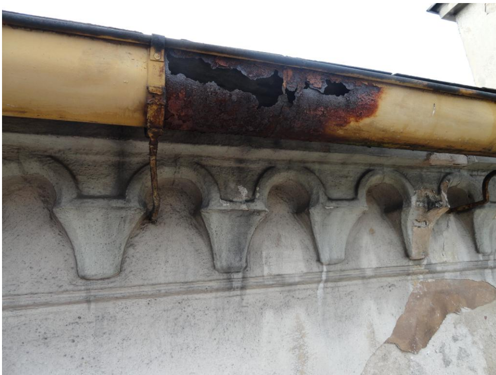
Fot.5. Widok gzymsu podrynnowego i rynny dachowej
