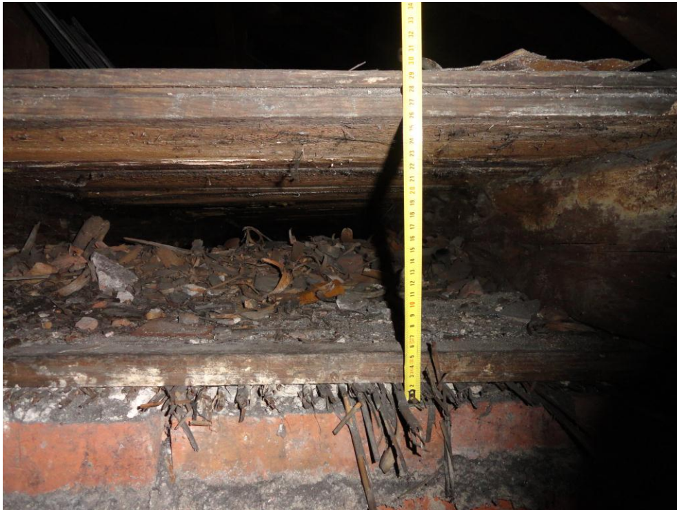
Fot.17. Przekrój przez strop belkowy nad salą
